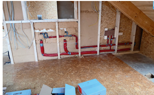
Blick in die Installationsebene des Dachgeschossbades. Neue Zwischenwände wurden in Trockenbauweise erstellt.
