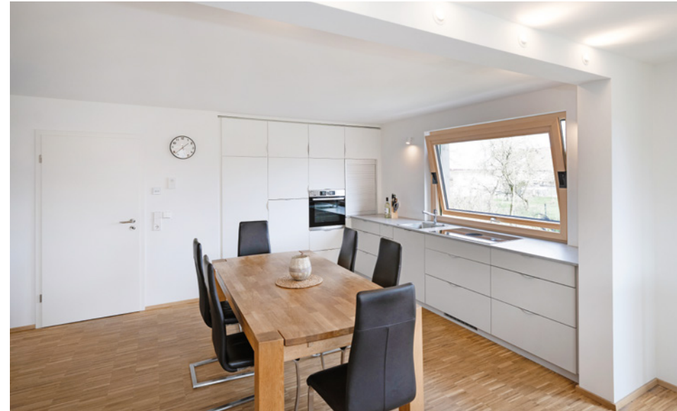
Ein Stahlträger in der Decke übernimmt die statische Funktion einer entfernten Zwischenwand. Praktische Besonderheit: das Klapp-/Schwingfenster.
