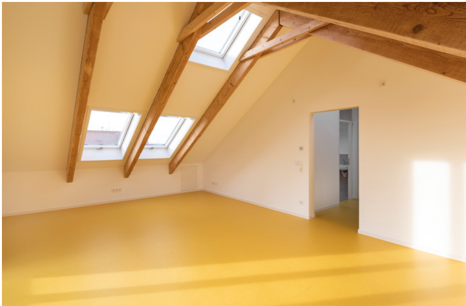
Gauben hätten das statische Gefüge stark beeinträchtigt. Mehrere Dachflächenfenster sorgen jetzt für viel Tageslicht.
