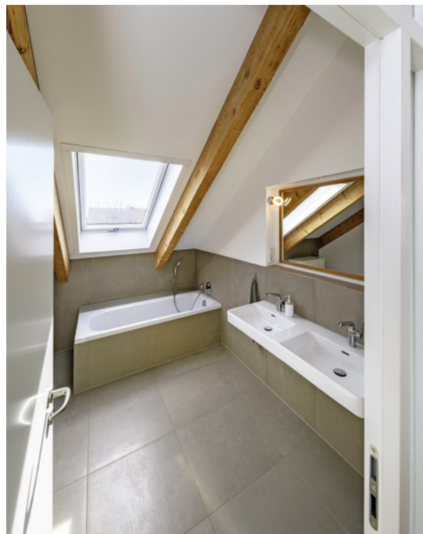
Blick in die Installationsebene des Dachgeschossbades. Neue Zwischenwände wurden in Trockenbauweise erstellt.
